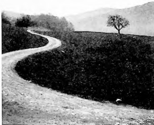
Die Bauparzelle „Auf dem Kirchenfeld“ oberhalb Mümliswil - November 1937
