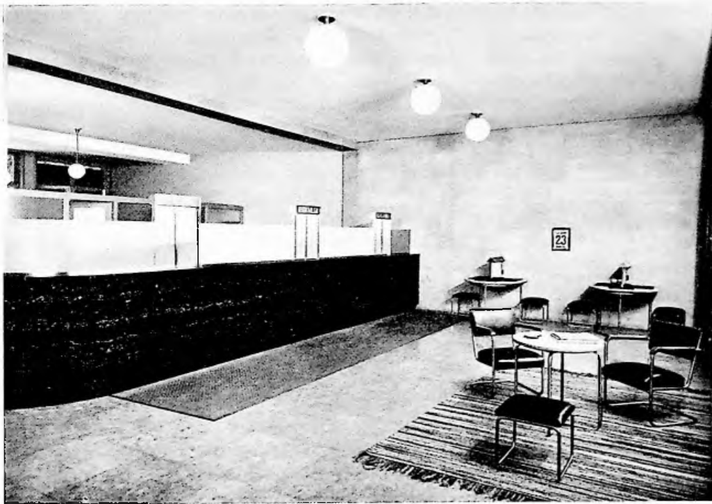
Schalterraum der Genossenschaftlichen Zentralbank
